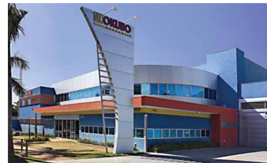
Projeto de uma clínica odontológica e oftalmológica a partir de uma residência dos anos 60. Aproveitamento e readequação das formas retas da residência existente. O projeto possui salas comerciais no térreo e no fundo do terreno, sendo Oftalmo no primeiro nível e Odonto no pavimento superior. A maioria das paredes existentes foi mantida e assim adaptamos os ambientes originais da casa à funcionalidade da clínica. Isso proporciona ao cliente uma enorme economia e desta forma consegue-se investir um pouco mais na fachada e acabamentos em geral. Uso de madeira, vidro e tijolos aparentes dão ao projeto moderno um ar aconchegante. As pedras de mosaico português amarelo no piso demarcam a rampa do acesso principal. O detalhe fica para a caixa branca que marca a entrada da clínica.
